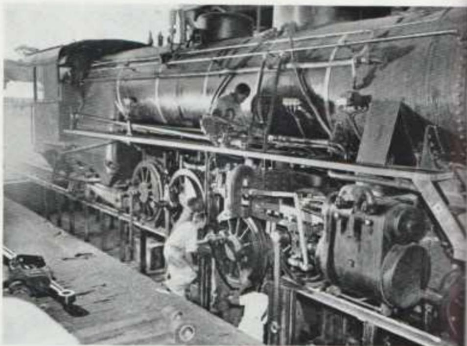
Mise en place d'un essai de locomotive dans un atelier de la Compagnie C. F. L. à Albertville.
